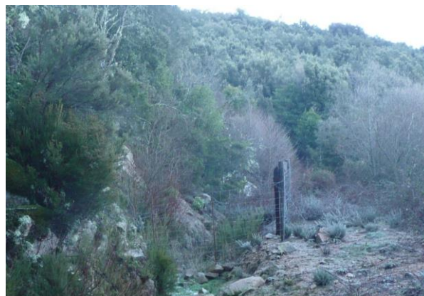
Captage d'eau potable
