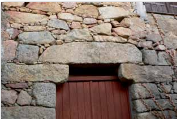
Porte d'entrée, côté aval
