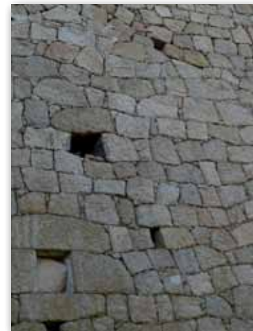
Le pignon révèle sous la surélévation un assemblage des pierres taillées pour être posées de chant, ce qui donne des effets d'ondulation.
