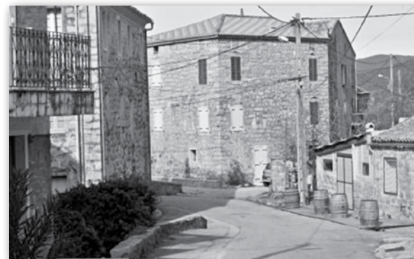
Elles se font face, au fond, la Casa di Caitucoli , une grosse maison, à allure de casone (toit à quatre pans) et, à gauche, la Casa di Poli .
