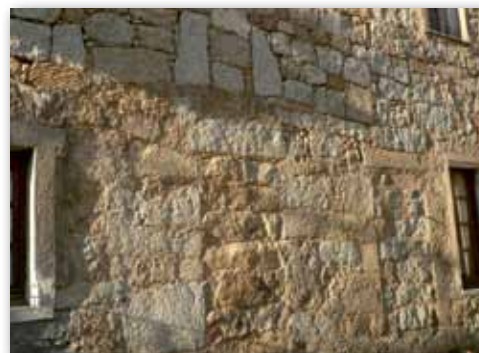
Obstruction de fenêtres, déplacement de la porte d'entrée, percement de nouvelles ouvertures, rejetées aux extrémités, escaliers et perrons d'accès à l'étage surélevé
