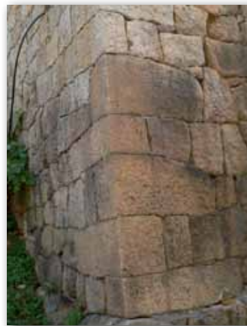
Les chaînages d'angles sont soignés.
